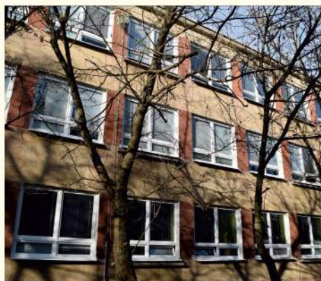
Budova základnej školy s novými oknami
