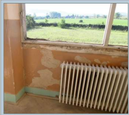
Okná základnej školy pred rekonštrukciou
