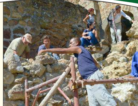
Felújítási munkálatok a várban (Fotó: Mesiarik Marian)
